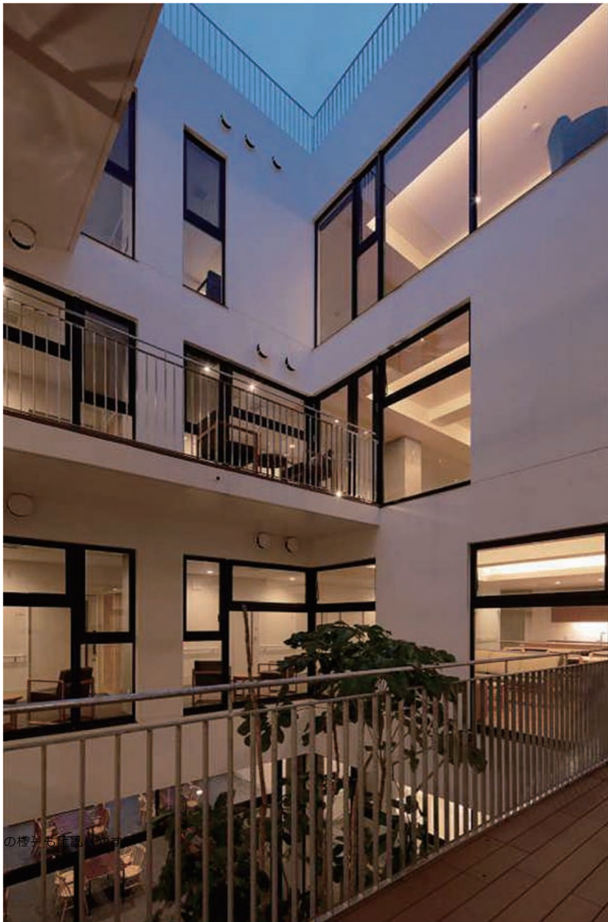
2階バルコニーから見た1階。階ごとにバルコニーの位置を変えているため、各階に光が届きやすく、互いの様子も確認しやすい
